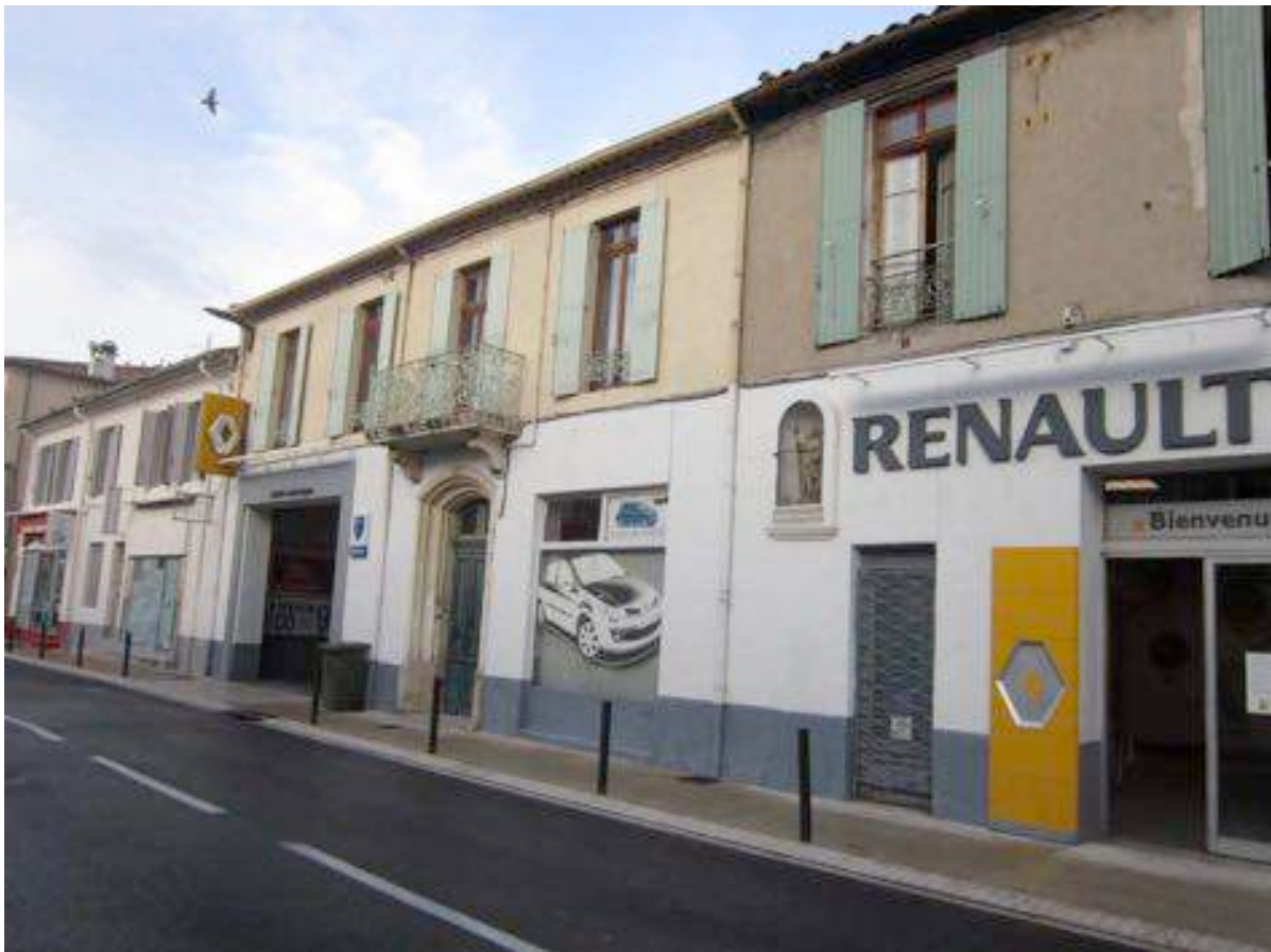
Façade sur rue République.
