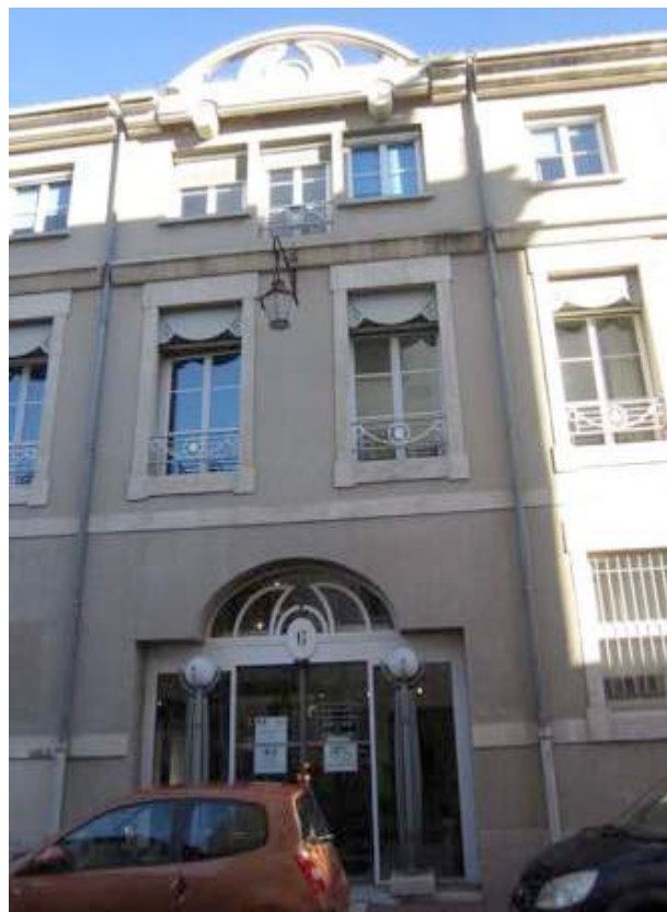
Travée centrale sur l'entrée.
