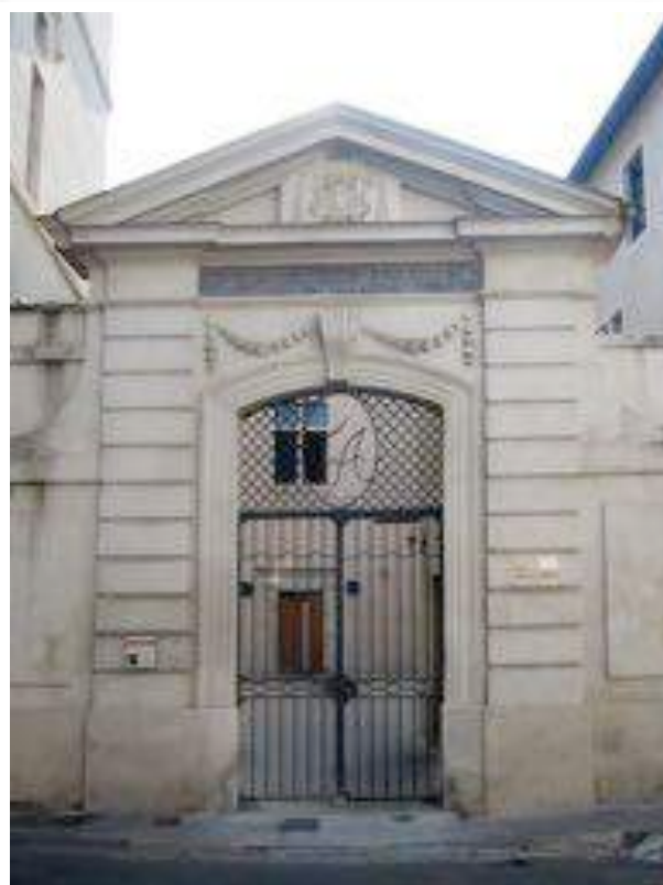
Porche d'accès au Foyer Albaric.
