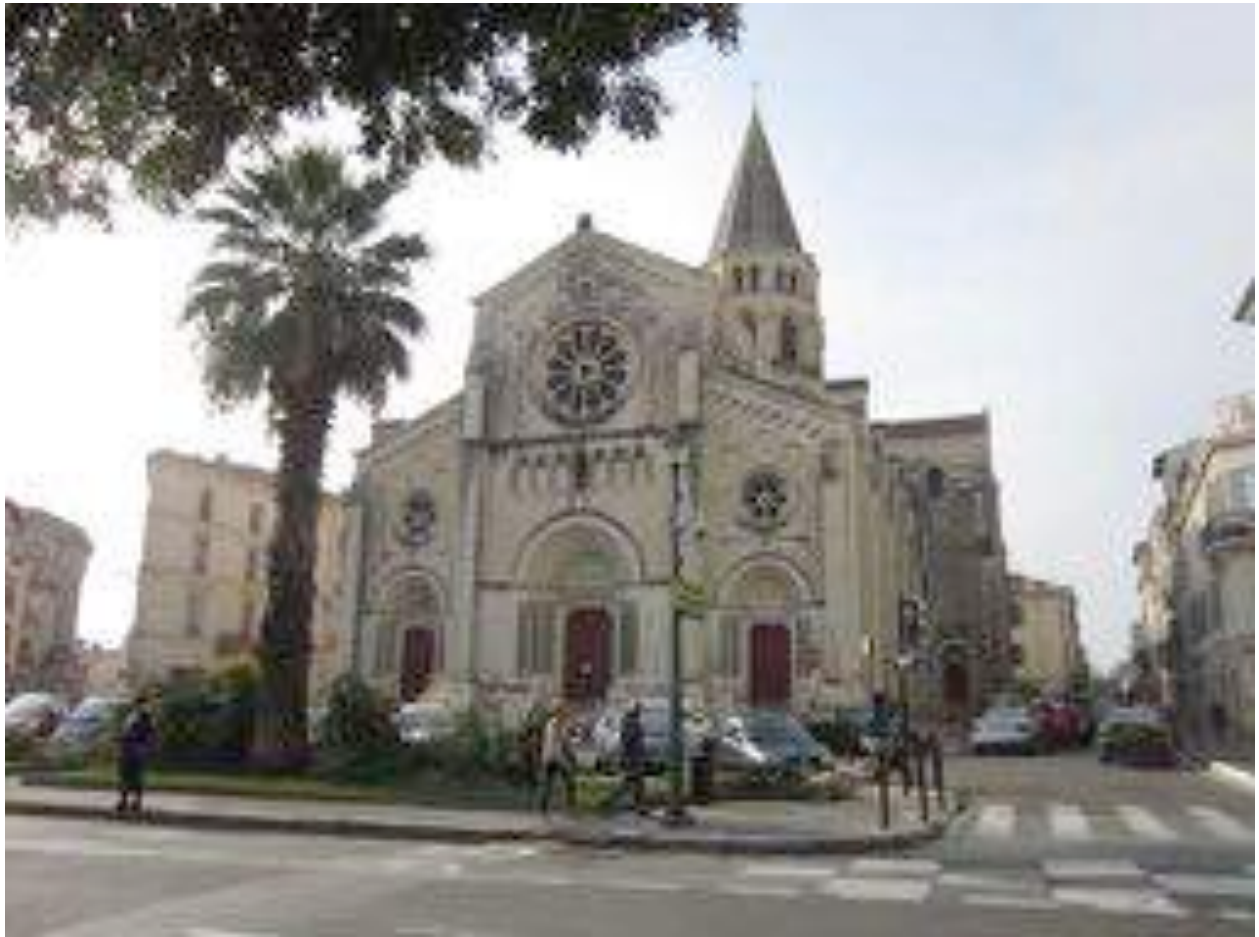
Façade est, en 2014
