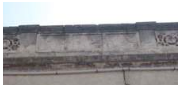
Mur acrotère, avec alternance de parties ajourées, et de parties pleines sculptées.
