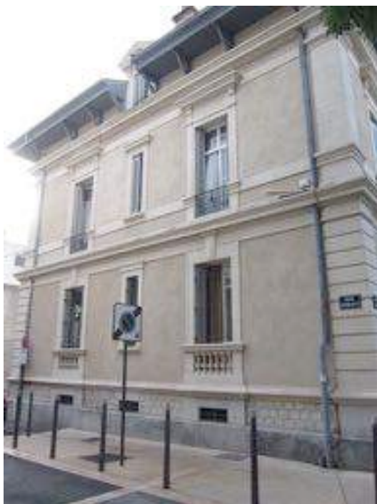
Façade sur rue Roumanille.
