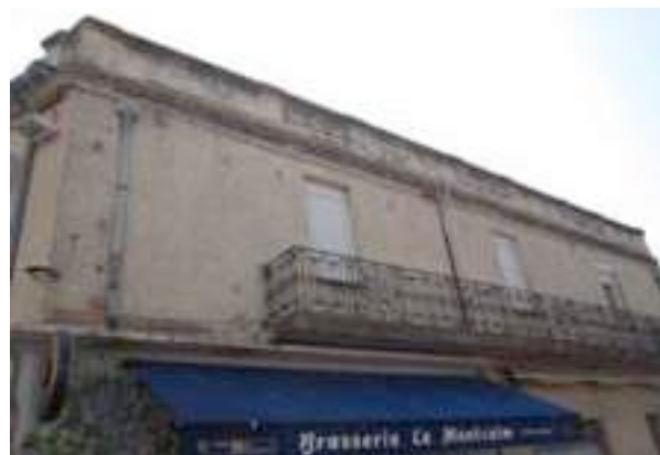
Façade sur la rue de Saint-Gilles.
