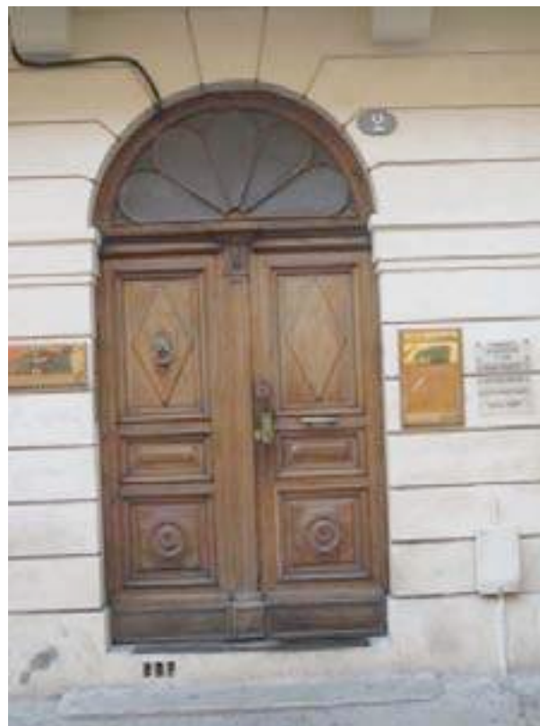
Très belle porte d'entrée, 2 rue Cité Foulc.
