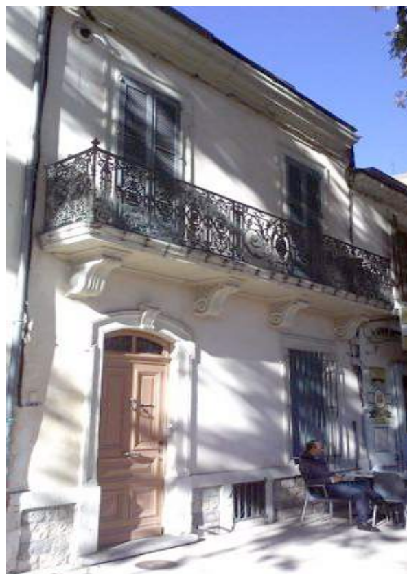
Vue d'ensemble de la façade.
