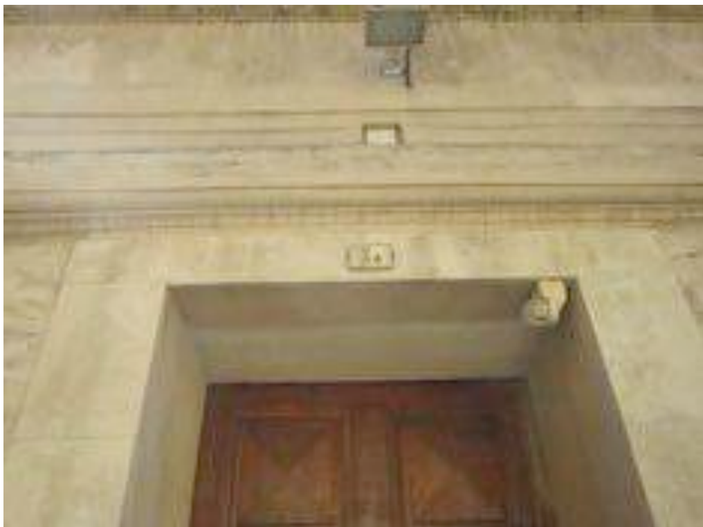
Entrée par la rue du Château FADAISE
