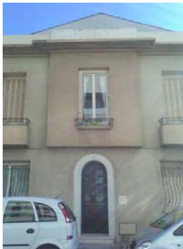
Encorbellement au dessus de l'entrée.
