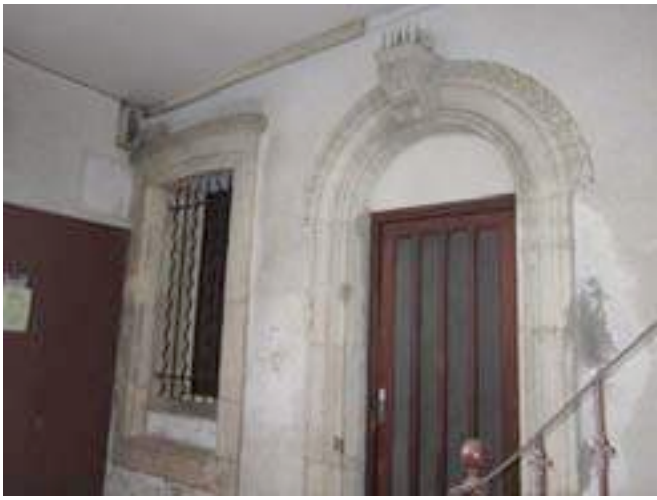
Ancienne façade au rez de chaussée, en recul d'environ deux mètres de la façade alignée sur rue, qui elle, est constituée d'une grille obturant une ouverture en arc surbaissé, avec une porte centrale, et deux allèges latérales.
