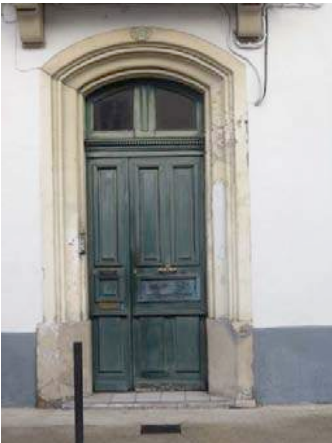
Entrée du 34 rue de la République. légende.
