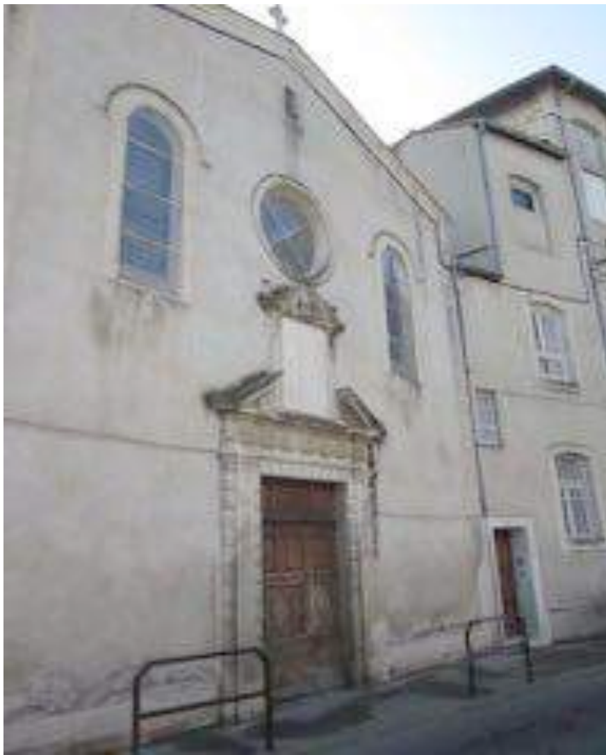
Vue d'ensemble de la façade, sur rue Jean REBOUL.
