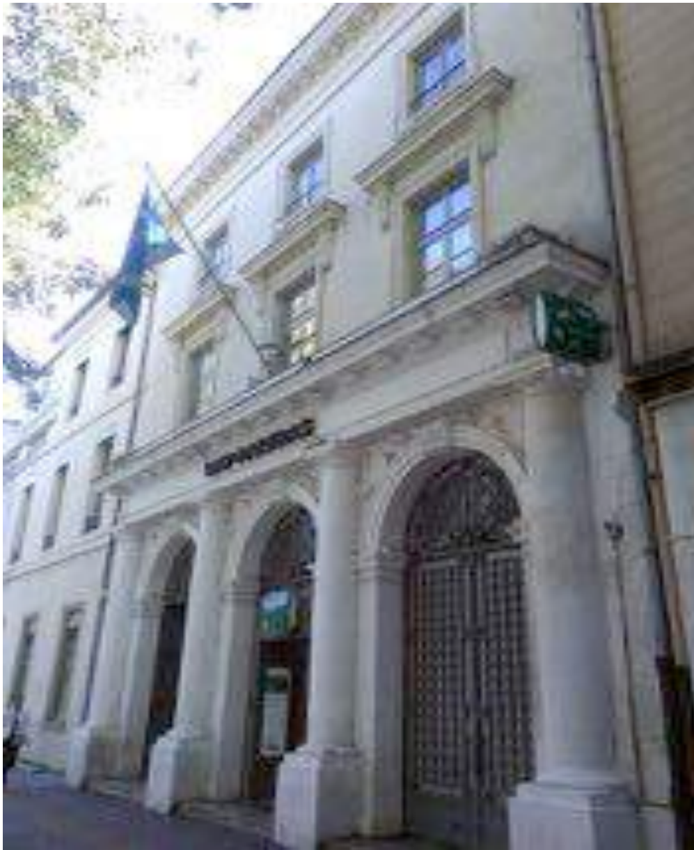
Façade du 17 boulevard Victor Hugo. Son dessin est apparenté au travail de l'architecte Alfonse de Seynes.
