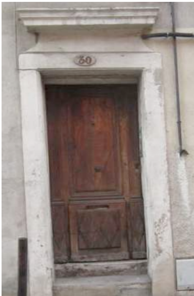
Entrée, 30 Rue Porte de France.
