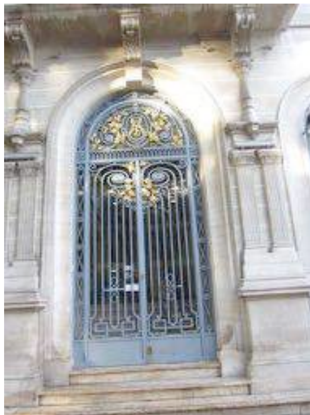
Ferronnerie de l'entrée : porte 2 vantaux, avec imposte ouvragée, portant le monogramme
