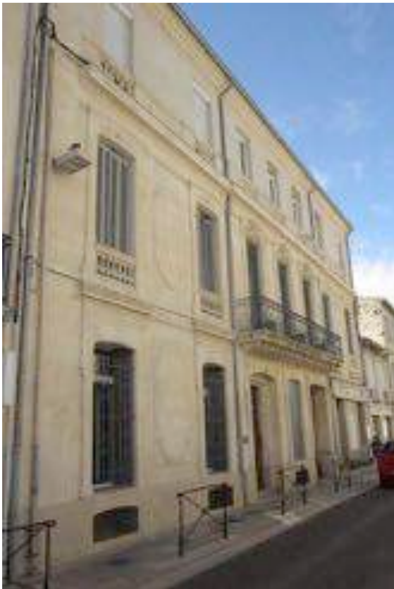
Une note dommageable : la non-homogénéité des menuiseries PVC du R+2. (Avec ou sans imposte, avec ou sans volets roulants)
