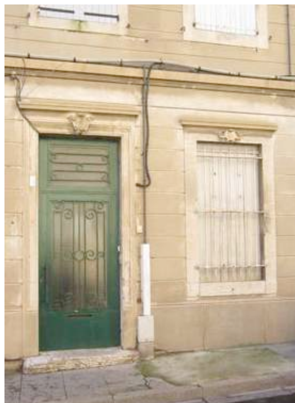
Entrée de l'immeuble.
