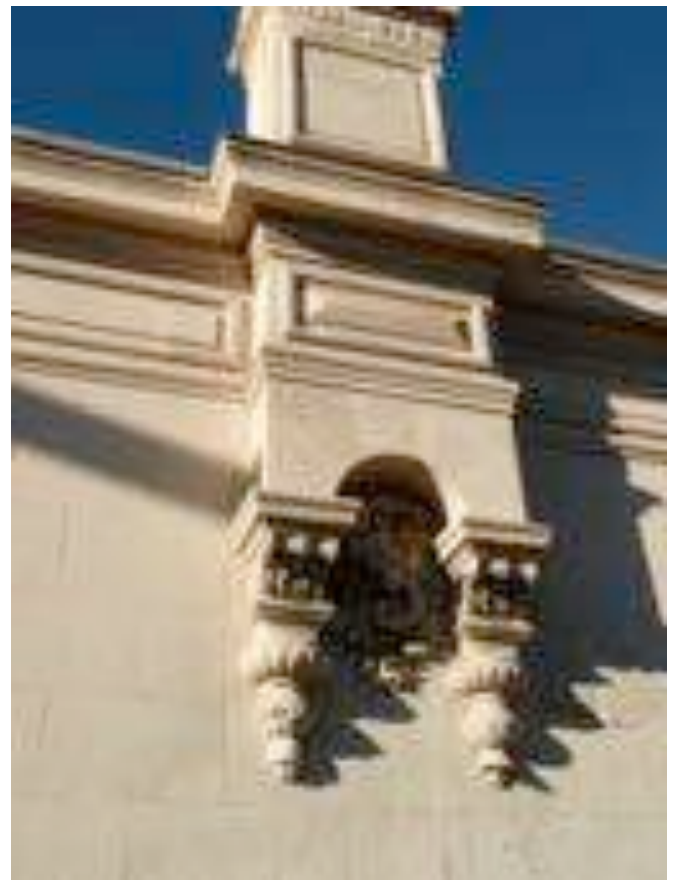
Cheminée en encorbellement, protégeant la Salamandre.
