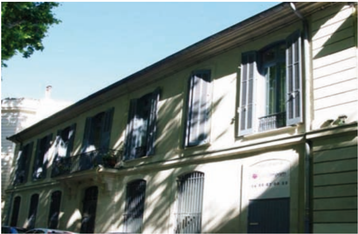
Façade sur Quai Fontaine :
