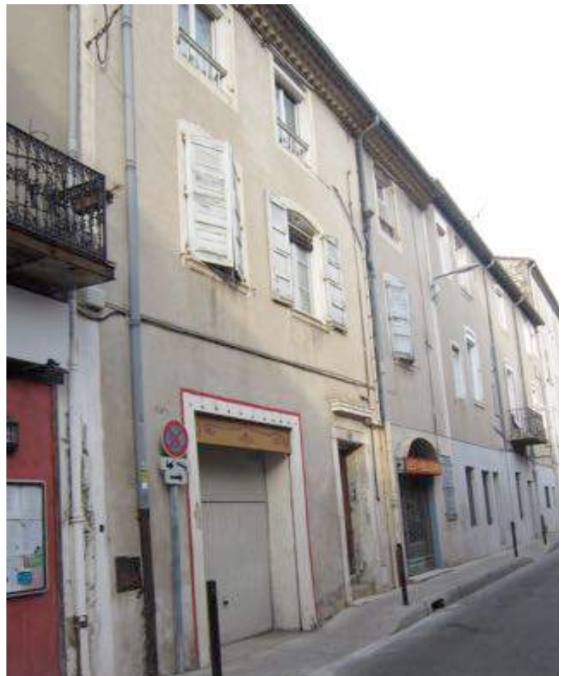
Façade Rue Porte de France.
