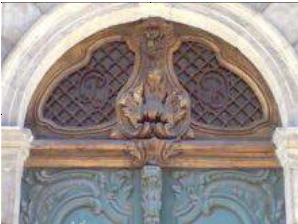
Détail de l'imposte sur la porte d'entrée, avec les initiales « P » et « B ».
